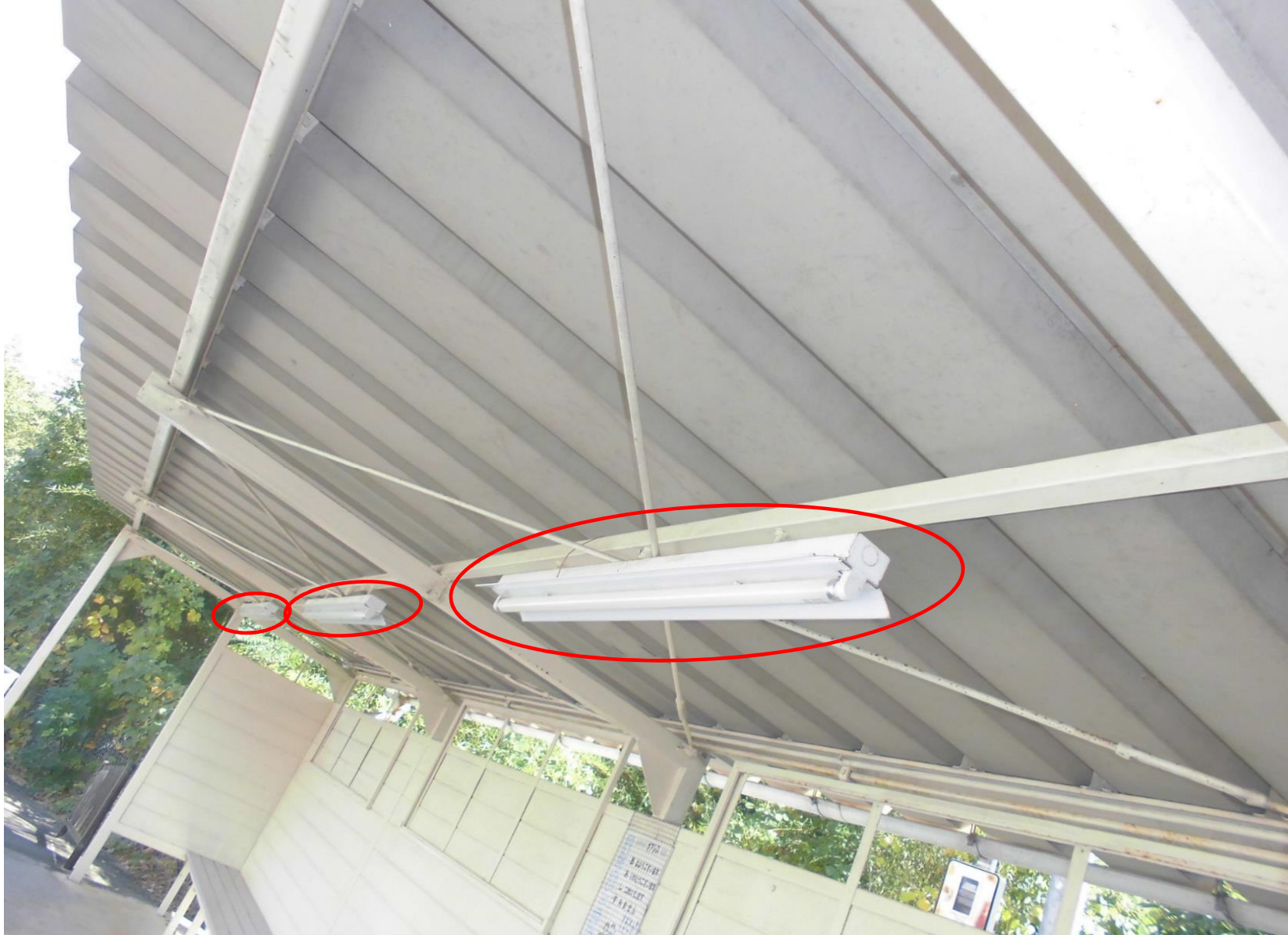
一連式（FLR40SW/M/36 36ワット）3基をLEDに
