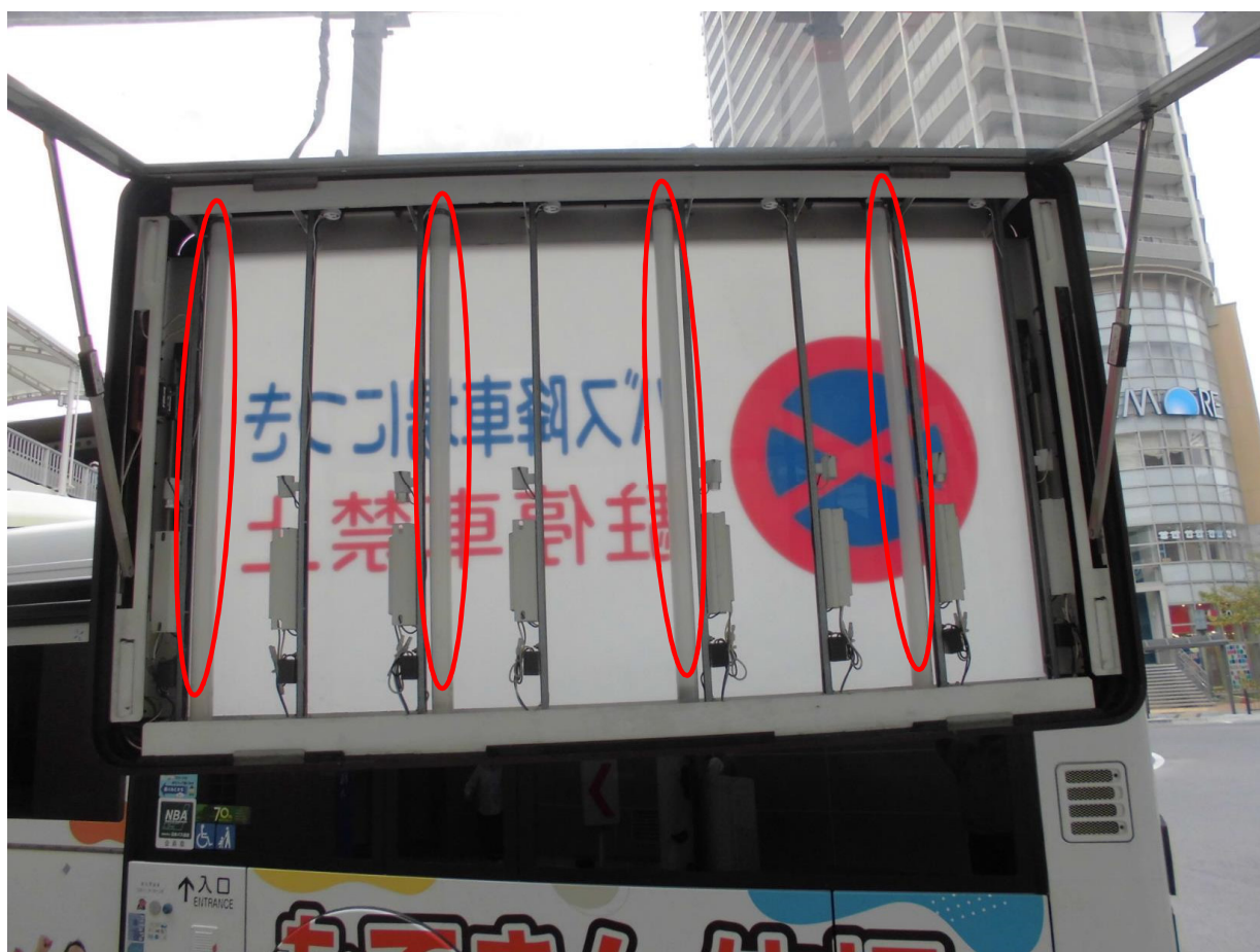
現在蛍光灯を全て使用中（同等程度の明るさ（LEDに交換）
