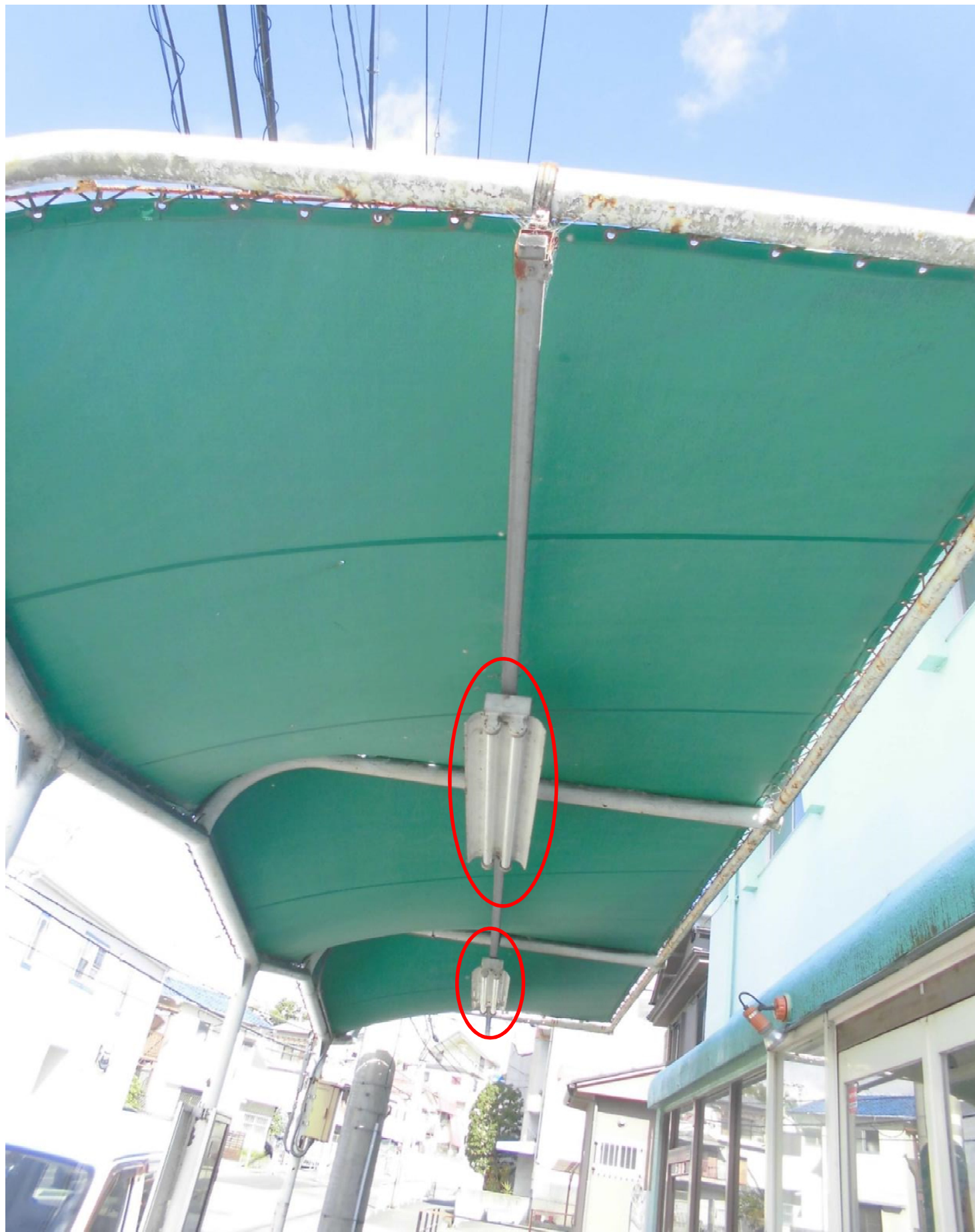
二連式（FLR40SW/M/40ワット）2基をLEDに
