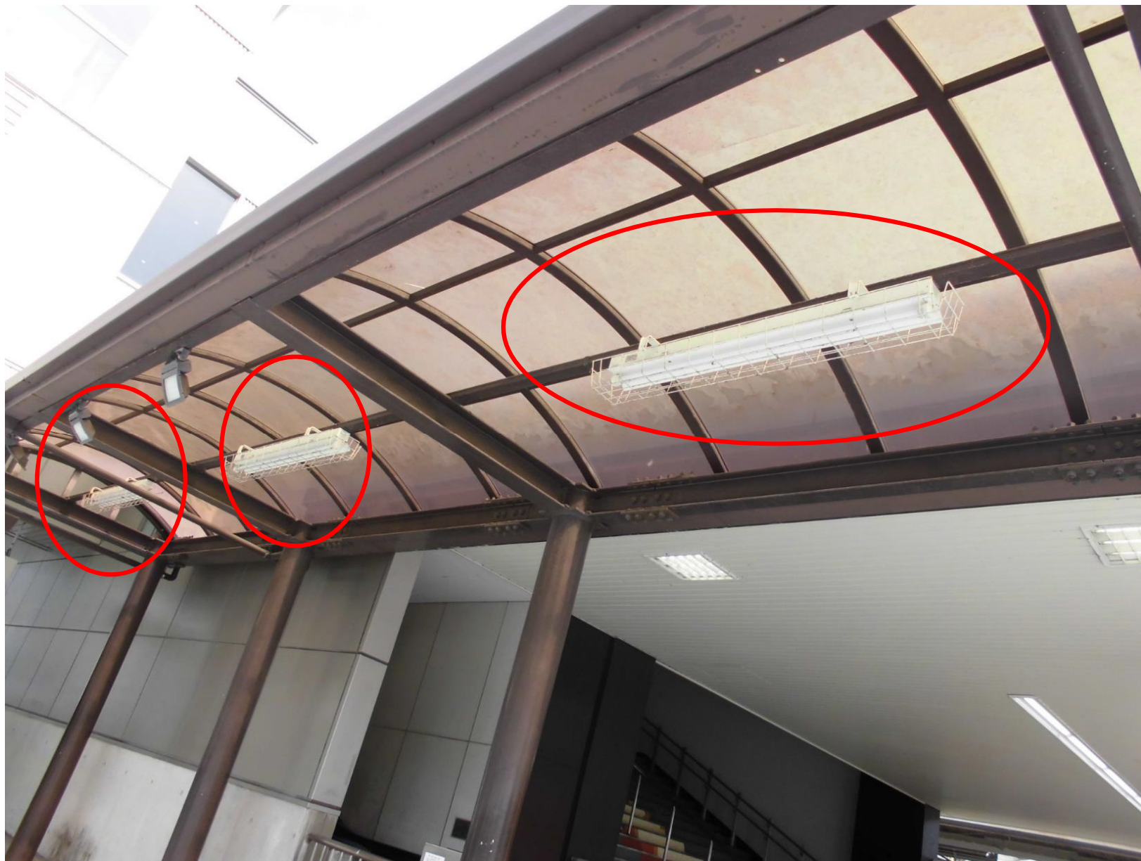
一連式 (FHF63EN-G) 3基をLED化
