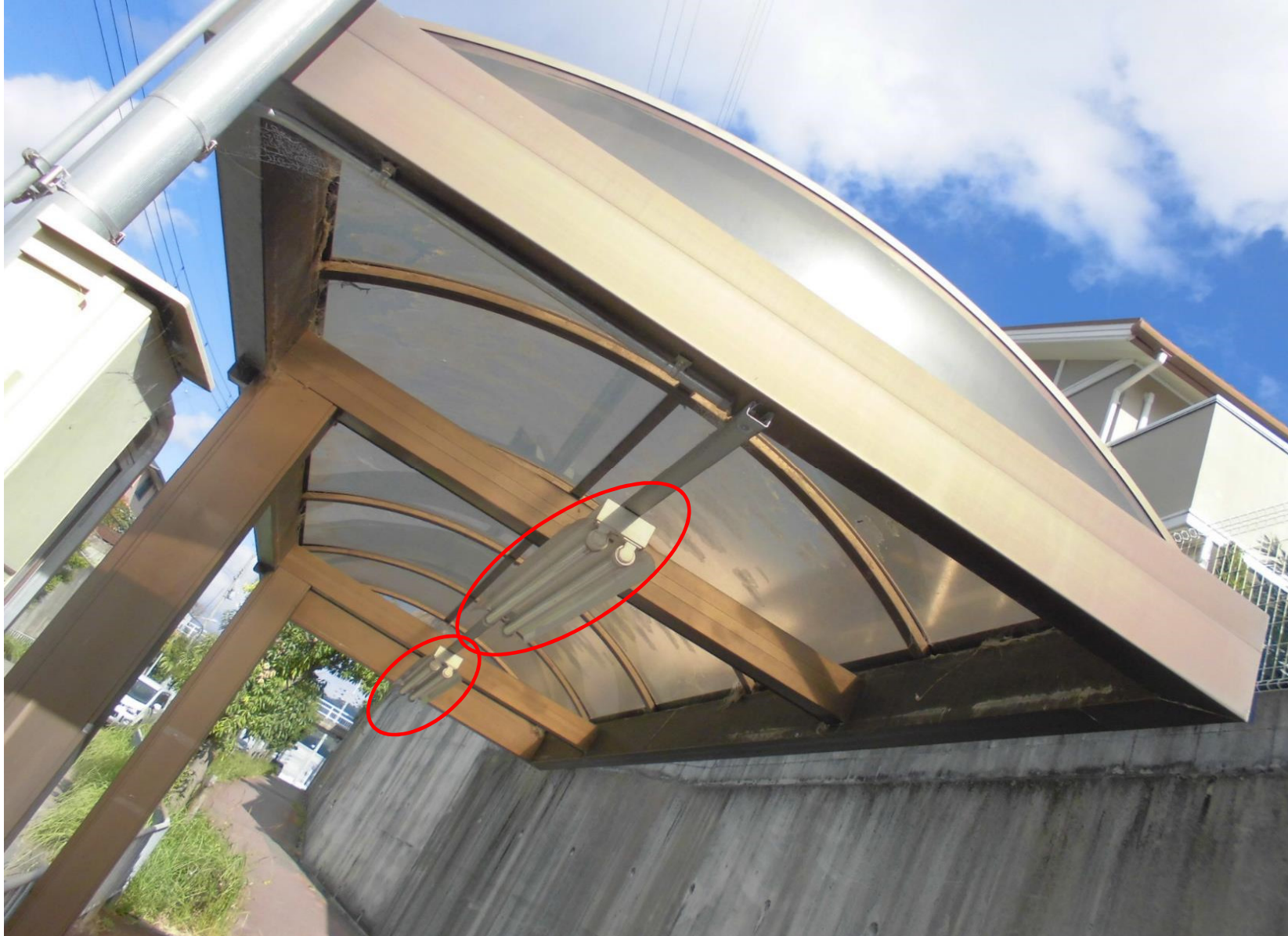
二連式 (FLR40S-D/M-X36 40形 36ワット ラピットスタート) 2基をLEDに
