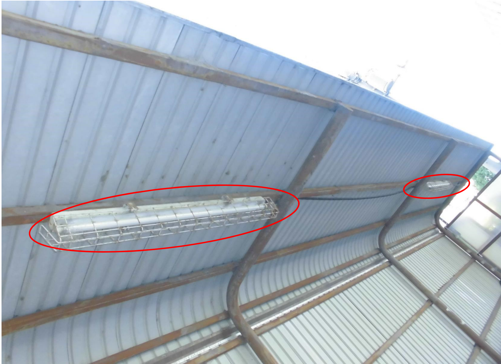
一連式 (FLR40SW/M ラピットスタート 白色 40ワット) 2基をLED化
