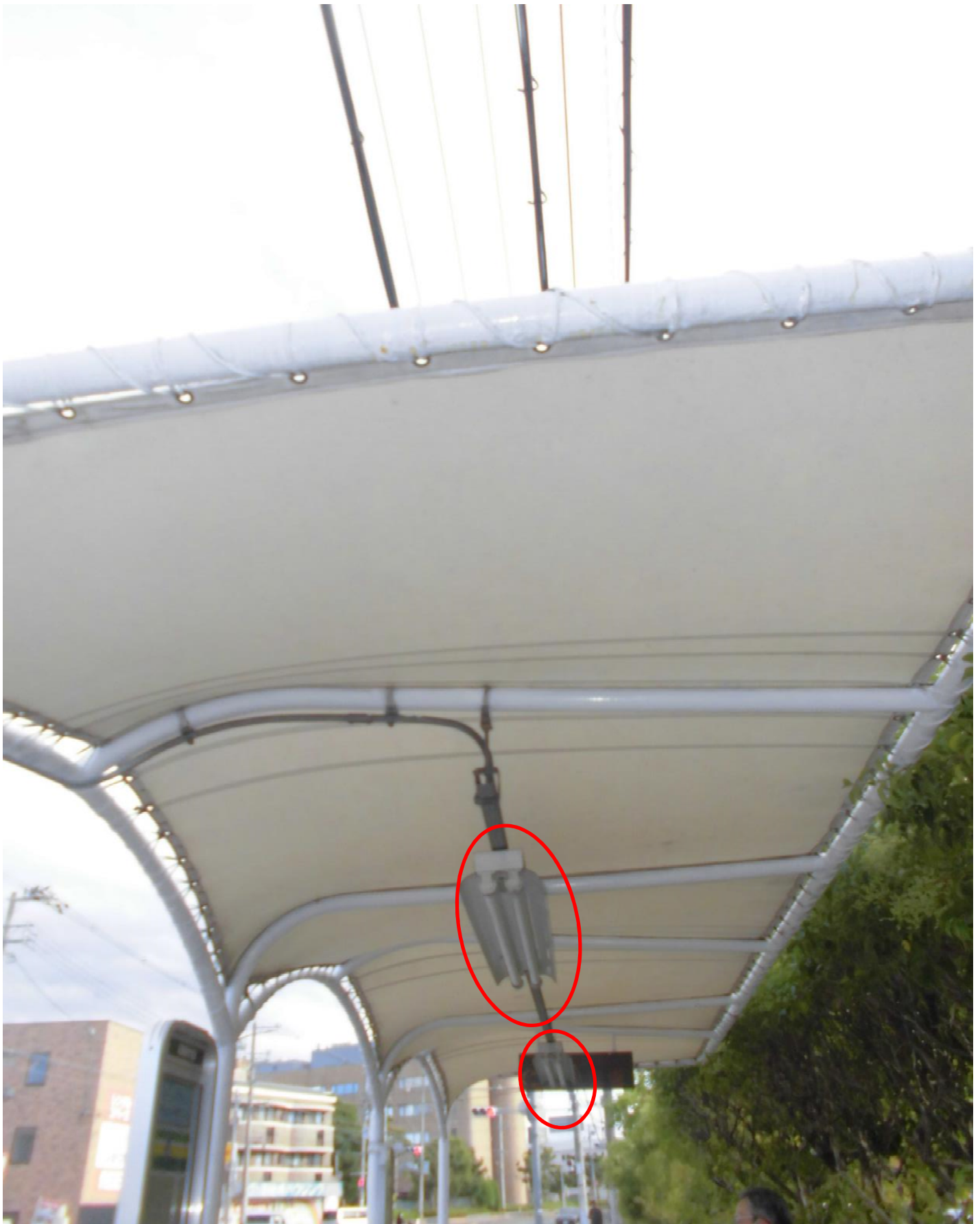
二連式（FLR40S-W/M-X-36 36ワット ラピットスタート）2気をLEDに
