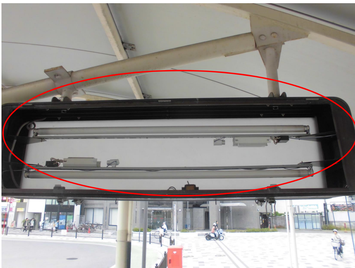
現在虽LEDランプで使用中 (同等性能の明るさLEDに交換)
