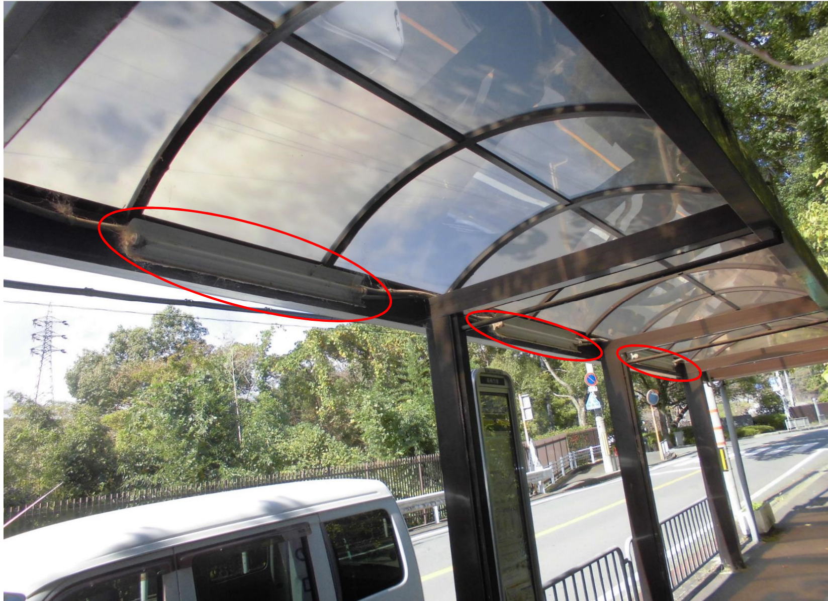
一連式 (FHF32EX-N-K 32ワット) 3基をLEDに
